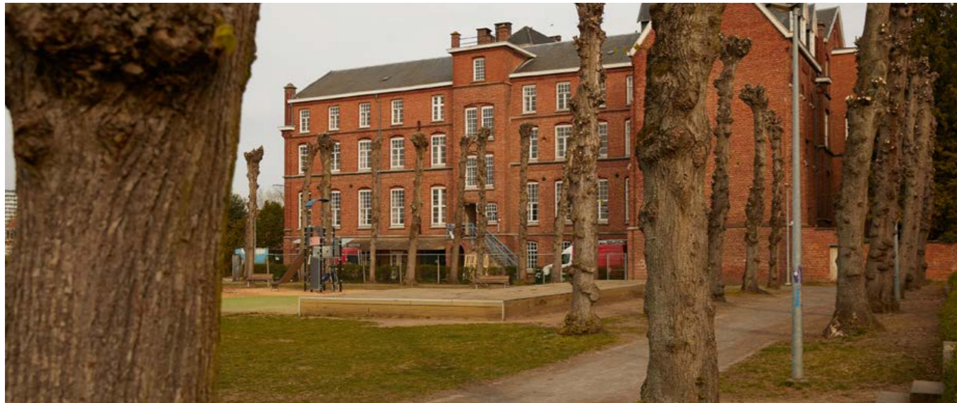
© Tim Buelens/stad Leuven - De werkzaamheden aan de Paul Van Ostaijensite op de Ruelensvest zijn volop aan de gang. Op de plaats van het Guido Gezellehuis komen een oefenzaaltje voor Cirkus in Beweging, een grote polyvalente zaal, een ontmoetings- en ontvangstruimte en negen lesruimtes voor SLAC Conservatorium.
