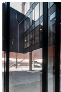
▲ De nieuwe kantoren voor de Centrale Diensten van de twee scholengroepen Arkorum & Sint-Michiel in Roeselare zweven boven een transparante sokkel. (© JAu fotografie en Architectengroep III)
