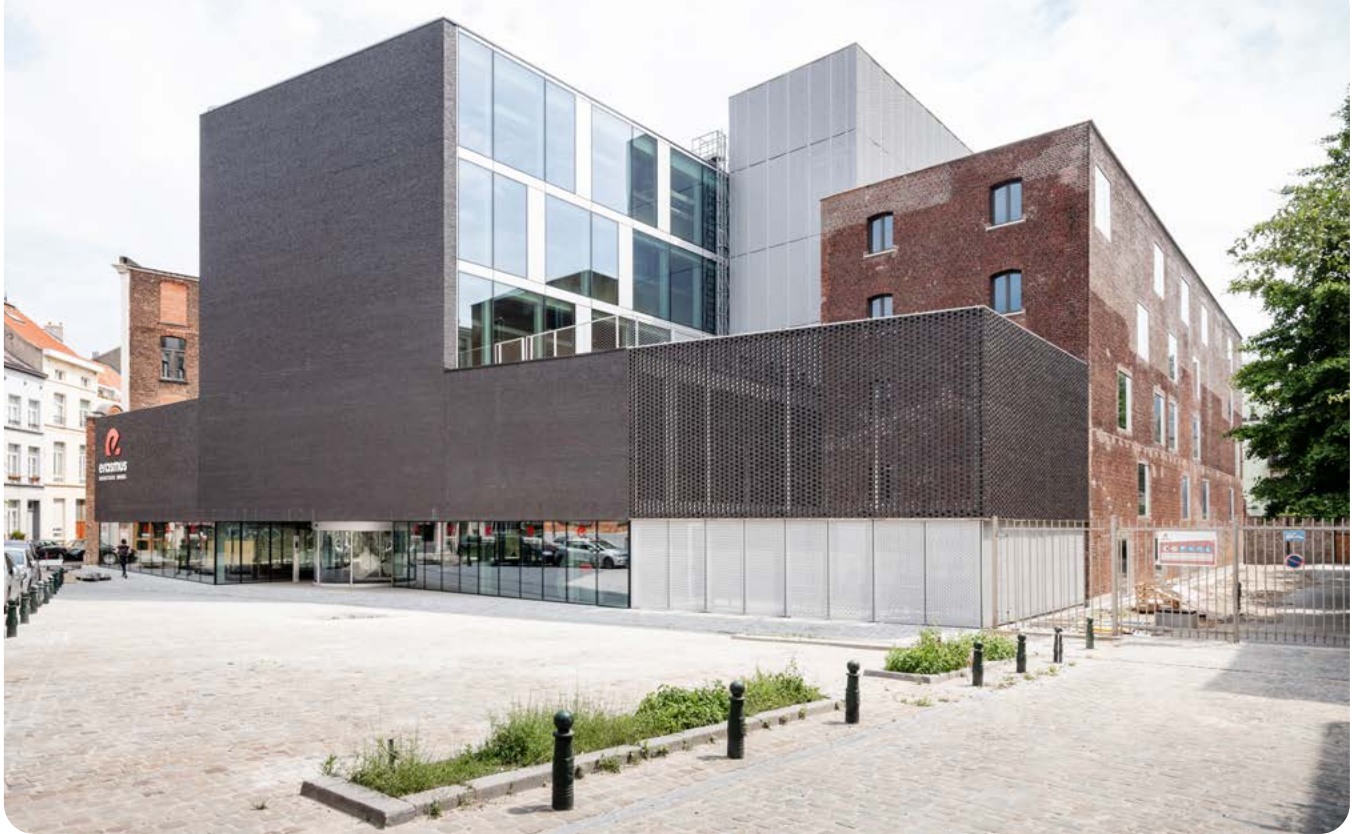
De nieuwe campus voor toegepaste wetenschappen en kunsten van de Erasmus Hogeschool bestaat uit een deel van de oude brouwerij en een transparante nieuwbouw met een glazen gevel. (© Lucid B architecten)
