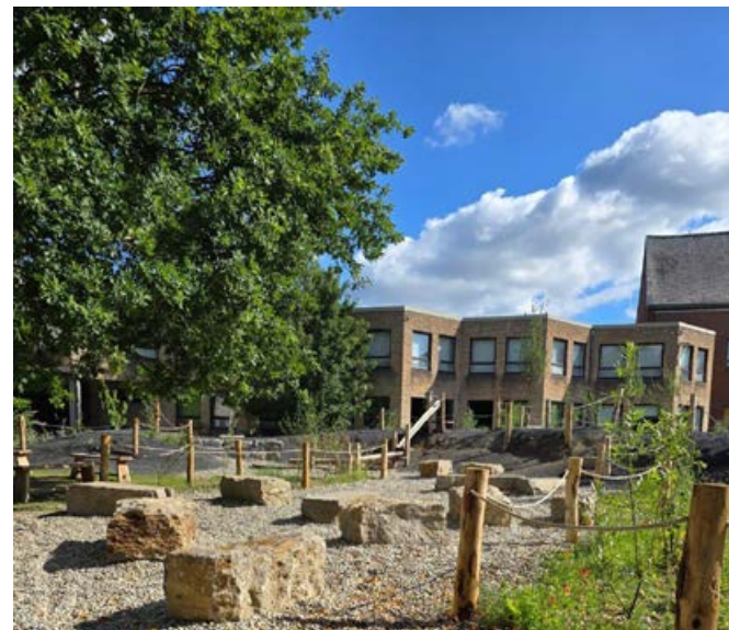
Biekorfje Aalbeke - Waar regenwater vroeger de kelder instroomde, wordt het nu opgevangen en geïnfiltreerd in de bodem
